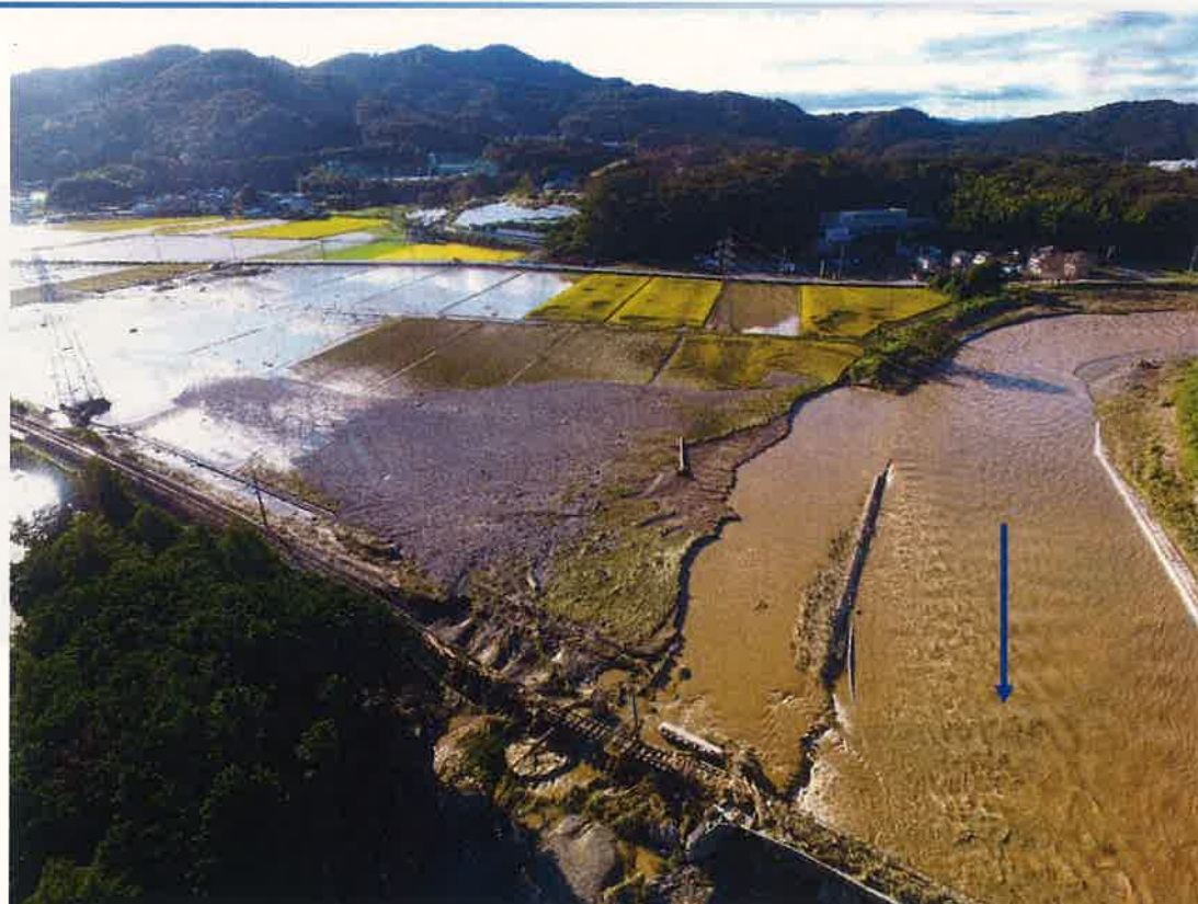
一級河川 永野川 改良復旧事業
