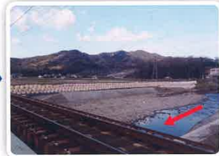
応急仮工完了
