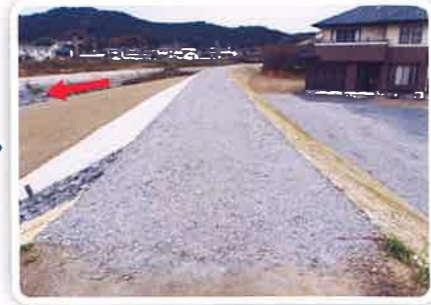
応急工事完了
