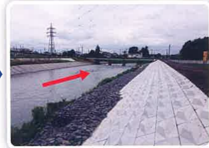
応急工事完了
