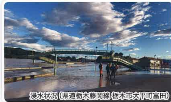
浸水状況(県道栃木環状線(栃木市函部町2丁目))
