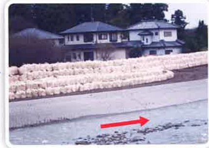
応急仮工完了
